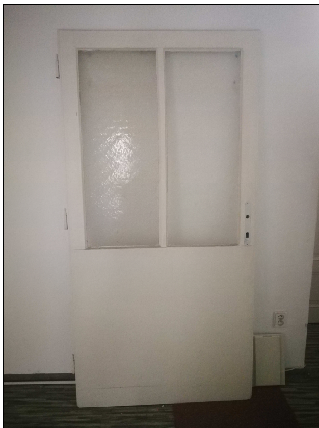
Obr. č. 13 – Vysazené dveřní křídlo do stěny do kuc
